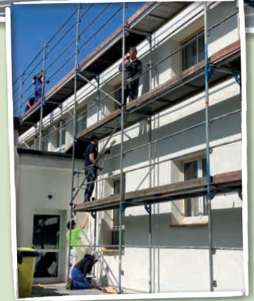
Renovierung der Fassade am Haus Rehbachtal
