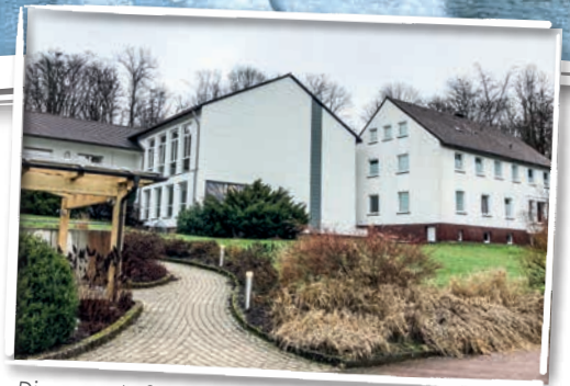
Die neue Außenfassade am Gebäude des Konferenzsaales
