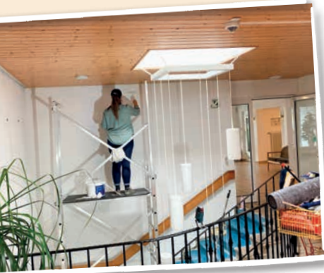
Beim Streichen des Treppenhauses
