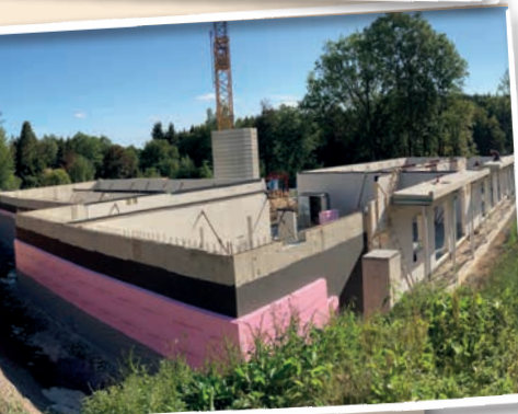
Auf der Baustelle des Neubaus geht es mit großen Schritten voran
