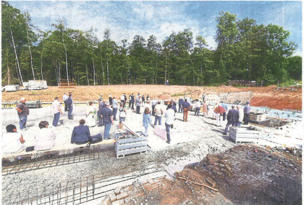
Politiker, Spender, Referenten, Freunde und Mitarbeiter haben beim Christlichen Gästezentrum Westerwald in Rehe die feierliche Grundsteinlegung miterlebt. Im zweiten Quartal 2021 soll das neue Domizil bezugsfertig sein. Die Kosten werden mit vier Millionen Euro beziffert. Das bisherige Haus Bergfried soll zu einem späteren Zeitpunkt abgerissen werden. Dort entsteht dann eine Mehrzweckhalle für Sport und Konferenzen. Fotos: Gästezentrum
