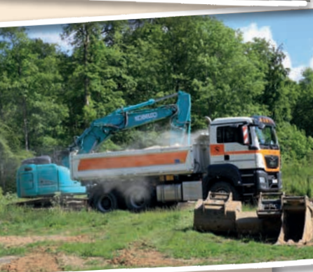
Bilder oben: Die Bagger rollen an. Die Erdarbeiten haben begonnen.
