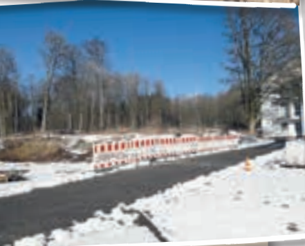
Bild oben: Abriss der alten Werkstatt und Wagenhalle
